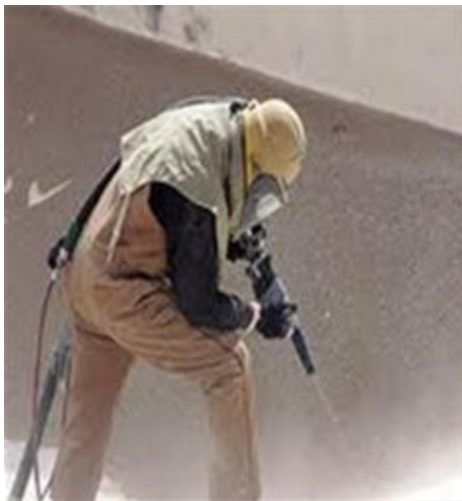
تصویر شماره ۱۶: تصاویر عملیات سندبلاستینگ
